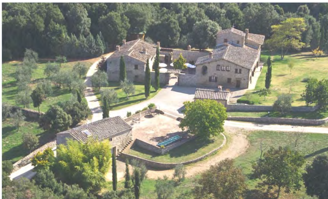
Foto 1 Complesso edilizio "Il Gallinaio".
